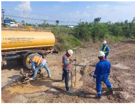
รูปที่ 2-57 (ต่อ) เจ้าหน้าที่ทำการสำรวจ ตรวจสอบ เพื่อยืนยันตำแหน่งรวมถึงระดับความลึกของท่อส่งก๊าซฯ และระบบสาธารณูปโภคเดิม
