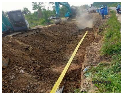
รูปที่ 2-56 การป้องกันท่อจากการขุดโดยบุคคลภายนอก
