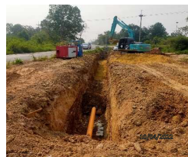
รูปที่ 2-11 การก่อสร้างวางท่อฯ ด้วยวิธีขุดเปิด โดยไม่เปิดหน้าดินพร้อมกันตลอดแนว
