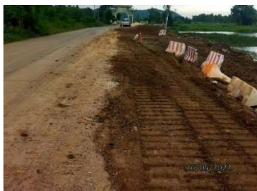
รูปที่ 2-18 การเผื่อปริมาณดินไว้ในกรณีดินยุบตัว
