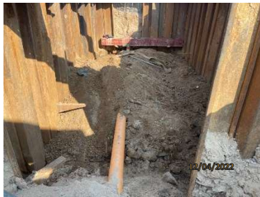
รูปที่ 2-20 การติดตั้ง Sheet Pile บริเวณพื้นที่รื้อขุด
