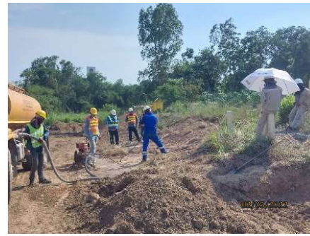
รูปที่ 2-57 (ต่อ) เจ้าหน้าที่ทำการสำรวจ ตรวจสอบ เพื่อยืนยันตำแหน่งรวมถึงระดับความลึกของท่อส่งก๊าซฯ และระบบสาธารณูปโภคเดิม
