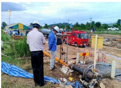
รูปที่ 2-29 การปรับลดแรงดันจากการทดสอบท่อด้วยวิธี Hydrostatic Test
