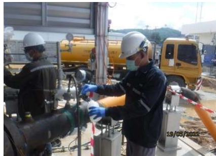
รูปที่ 2-30 การตรวจสอบคุณภาพน้ำทิ้งจากการทดสอบท่อด้วยวิธี Hydrostatic Test
