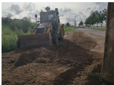
รูปที่ 2-18 การเผื่อปริมาณดินไว้ในกรณีดินยุบตัว
