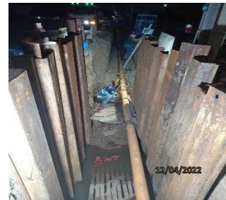
รูปที่ 2-20 การติดตั้ง Sheet Pile บริเวณพื้นที่รื้อขุด
