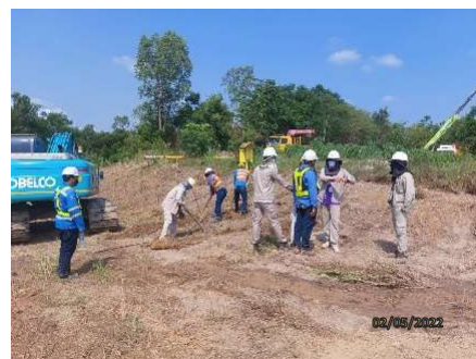
รูปที่ 2-57 เจ้าหน้าที่ทำการสำรวจ ตรวจสอบ เพื่อยืนยันตำแหน่งรวมถึงระดับความลึกของท่อส่งก๊าซฯ และระบบสาธารณูปโภคเดิม
