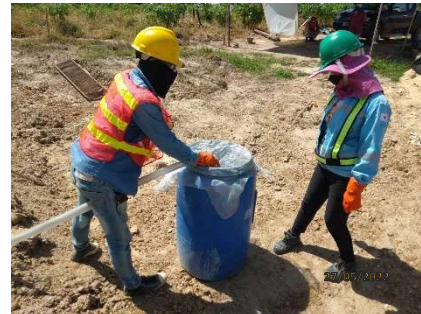
รูปที่ 2-28 การติดตั้งตาข่ายที่มีขนาดตาถี่ เพื่อดักตะกอนก่อนระบายน้ำทิ้ง
