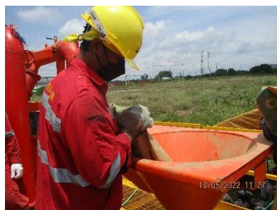
รูปที่ 2-37 การผสมผงโซเดียมเบนโทไนท์
