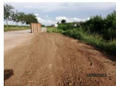
รูปที่ 2-18 การเผื่อปริมาณดินไว้ในกรณีดินยุบตัว
