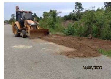
รูปที่ 2-18 การเผื่อปริมาณดินไว้ในกรณีดินยุบตัว
