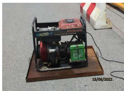
รูปที่ 2-23 ที่รองรับน้ำมัน ถาดรอง และวัสดุดูดซับ
