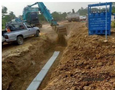
รูปที่ 2-56 การป้องกันท่อจากการขุดโดยบุคคลภายนอก
