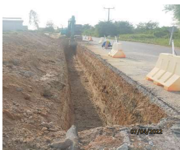
รูปที่ 2-11 การก่อสร้างวางท่อฯ ด้วยวิธีขุดเปิด โดยไม่เปิดหน้าดินพร้อมกันตลอดแนว
